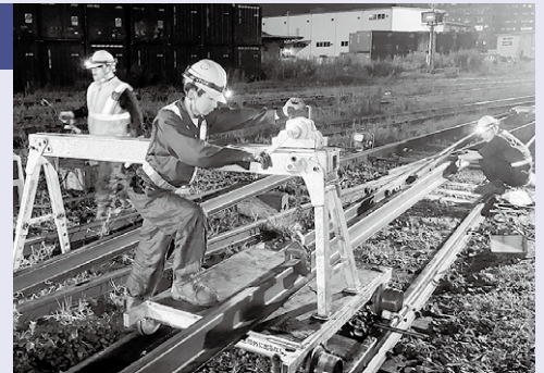
夜間に線路の保守作業をしている様子
