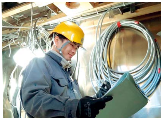
図面を見て電路の配置を確認している様子
